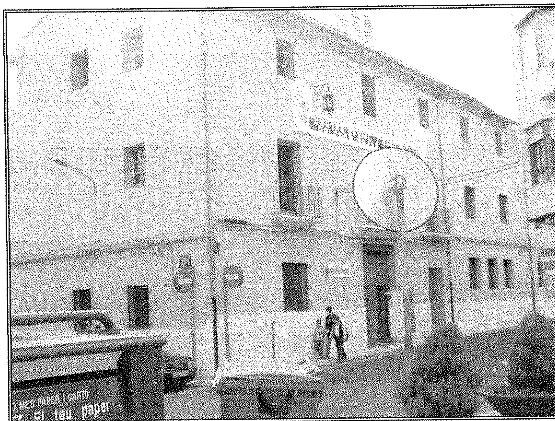
Exterior del edificio.
