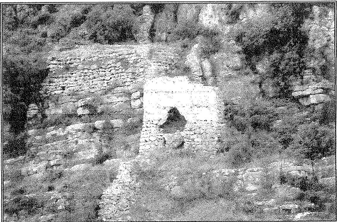
Torre y parte del lienzo defensivo
