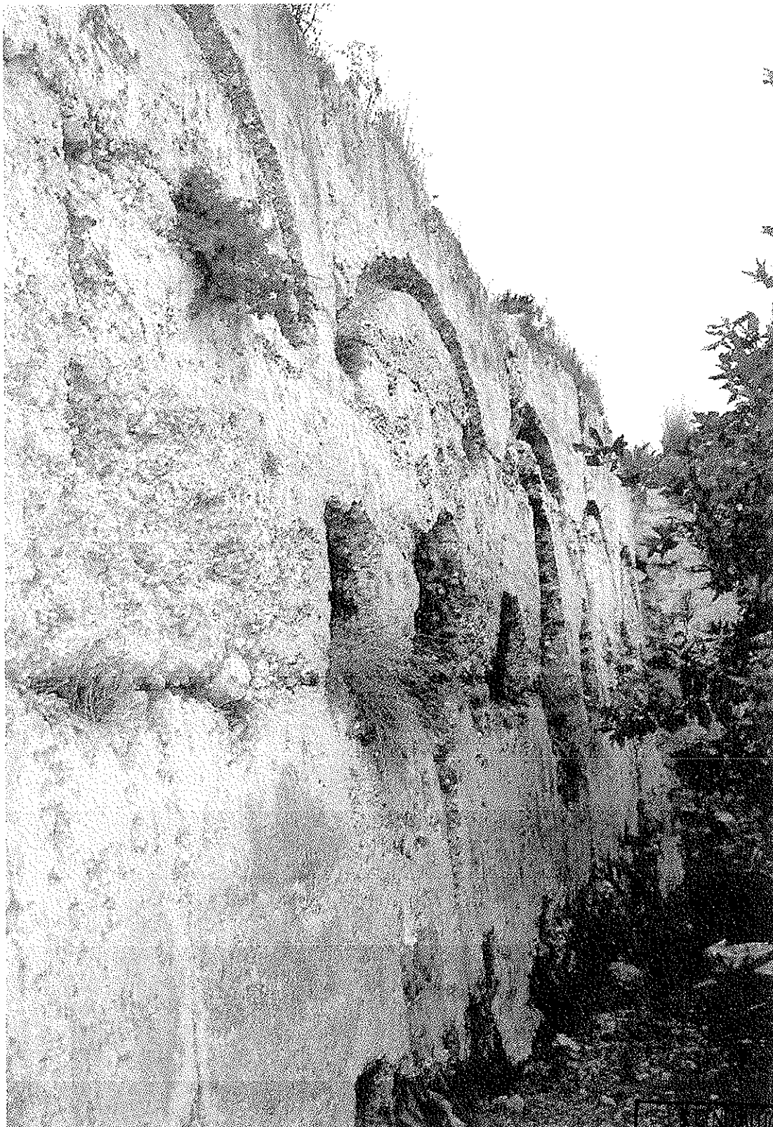
Vista del lienzo de protección.
