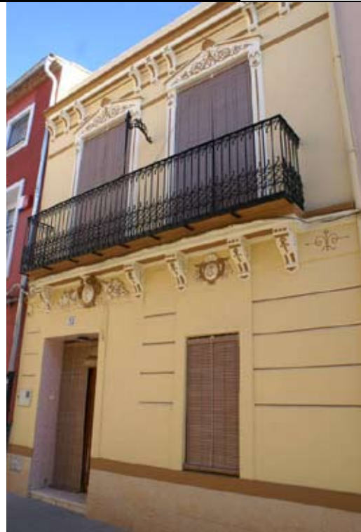
CALLE MAYOR N° 21 (Balcón a dos huecos)
