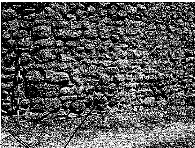
Detall del paviment d' opus signinum reaprofitat en el mur sud de la tanca del recinte del molí.
