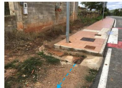
Retranqueo cuneta exterior y canalización a tramo entubado
