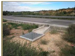
Relleno de zona deprimida, sustitución de barrera por bordillo y ejecución pozo de desagüe
